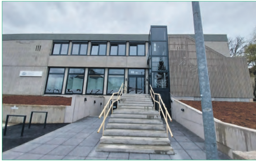
Die Sanierung des Hauses der Donauschwaben in Sindelfingen ist weitgehend abgeschlossen. Fotos: Peter-Dietmar Leber
