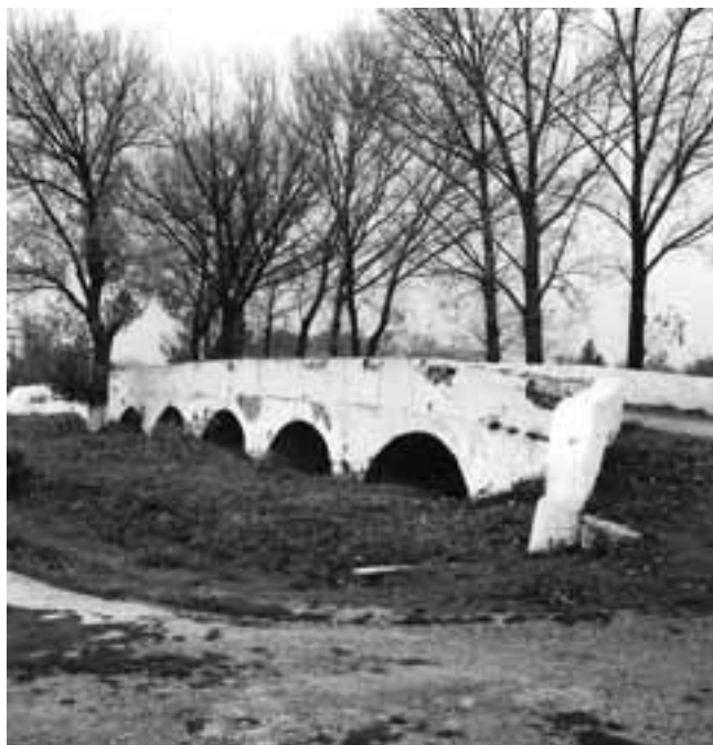
Eine der zwei im 16. Jh. in Altbeba erbauten Brücken
